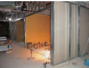
2階軽鉄間仕切り
