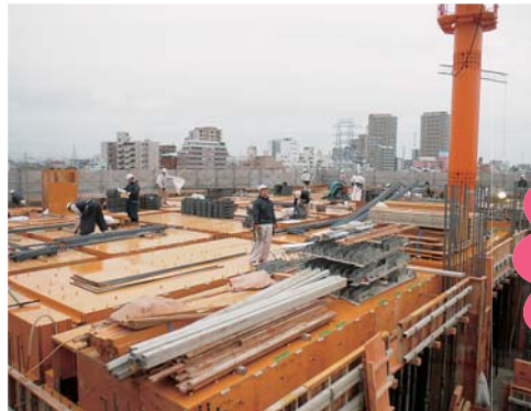
5階東側床の型枠工事
