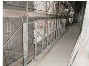
バルコニー面の有孔手すり
