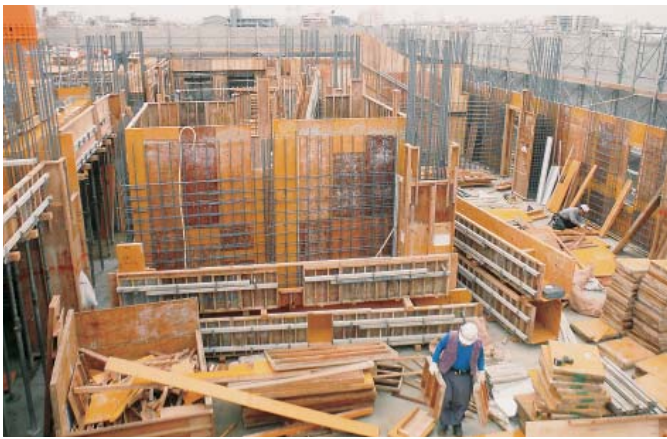
4階西側柱と壁の型枠工事
